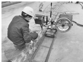
图 6.2-5 碎丝埋弧焊盖面
