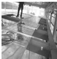
图 5.5-2 自支承 H 型钢现 浇楼盖施工照片
