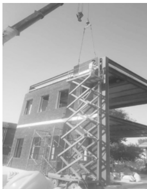
图 5.6-4 单元模块外墙板吊装
