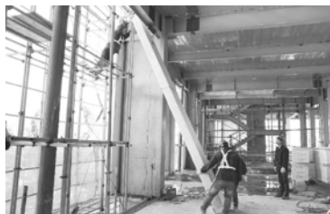
图 5.6-1 轻质自保温外挂条板安装 图 5.6-2 轻质自保温外挂大板吊装
