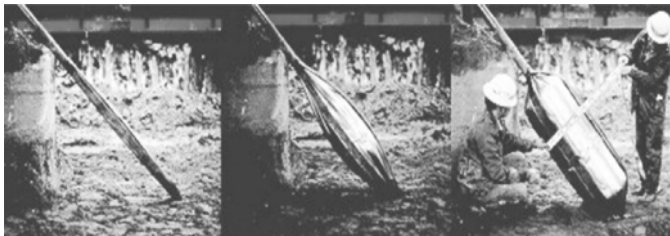
图 1.3-2 囊式扩体锚杆囊袋实物图
