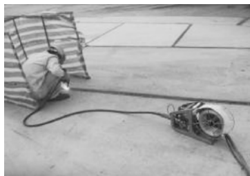
图 6.2-4 CO 2 气体保护焊打底
