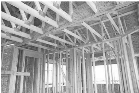
图 5.7-1 桁架齿板连接处的构件宽度 \geq 50 mm 时的连接方式
