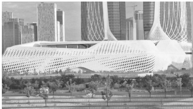
图 7.1.3-1 南京保利大剧院玻璃纤维增强水泥(GRC)板幕墙
