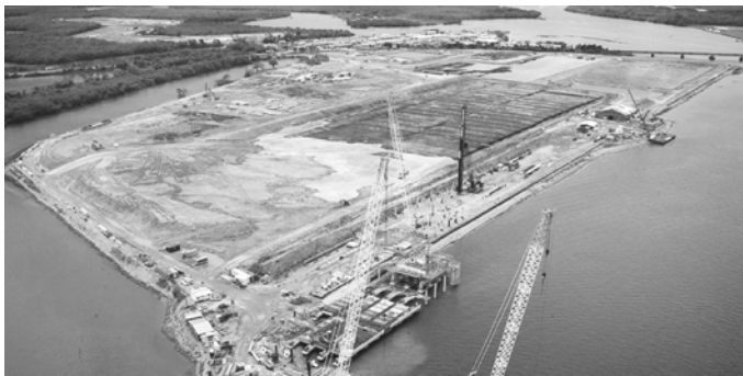
图 8.2-1 脱水土管系统工程应用场景
