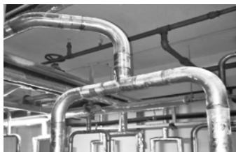
图 6.3.2-2 直管与直管连接
