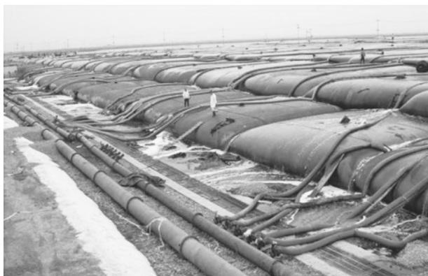
图 8.2-2 脱水土管系统工程泥浆现场原位处理图
