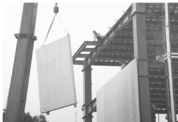
图 5.6-1 轻质自保温外挂条板安装 图 5.6-2 轻质自保温外挂大板吊装
